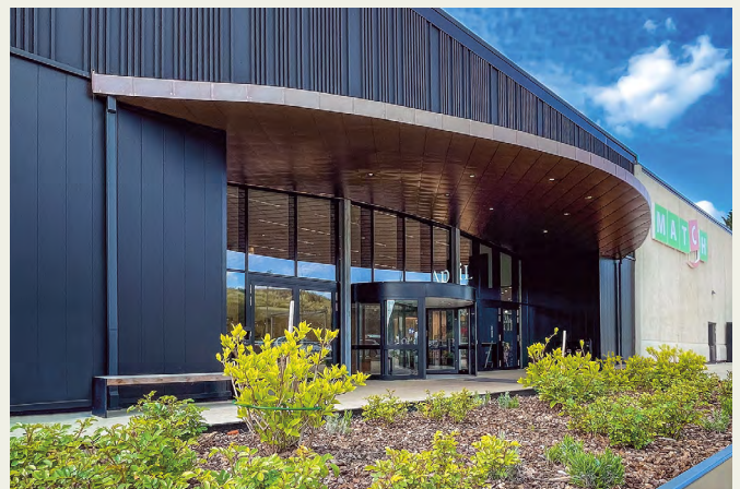
Nouvelle zone d'entrée du centre
